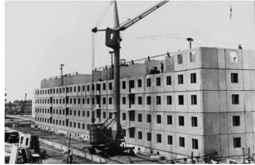
Строительство пятиэтажного жилого дома. Город Волжский
