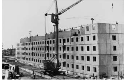
Строительство пятиэтажного жилого дома. Город Волжский
