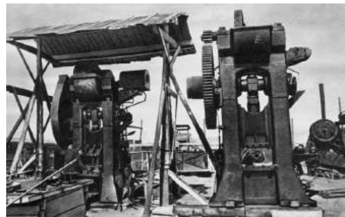
Монтаж оборудования на эвакуированном заводе. Казахстан. 1942 г.
