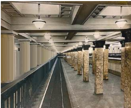
Станция метро «Комсомольская» Сокольнической линии («Комсомольская площадь»), Москва, 1935 г. Перронный зал
