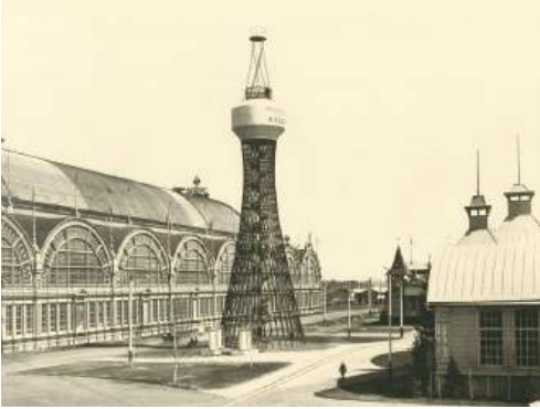
Гиперboloидная башня. Инженер В. Г. Шухов
